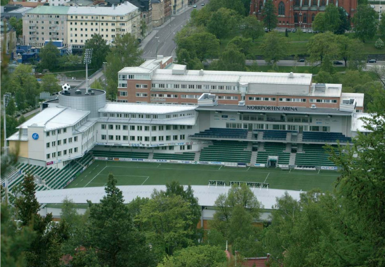
Norrporten Arena i Sundsvall, byggd enligt PPP/OPP. Foto: Sören Walldin/Sundsvalls tidning.
